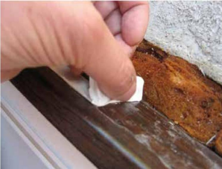
Wenn Schutzbänder auf der Oberfläche der Pulverbeschichtung verbleiben, insbesondere wenn sie dem Sonnenlicht und hohen Umgebungstemperaturen ausgesetzt sind, können sie zu chemischen Reaktionen führen, die zu einer Verklebung zwischen dem Band und der Pulverbeschichtung führen. Die Schutzbänder müssen unmittelbar nach der Montage entfernt werden.
